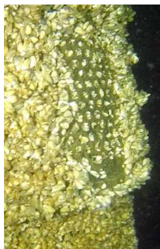
À gauche: vue sur une crépine lors de l'inspection en juillet 2022- une petite partie de la surface extérieure a été nettoyée par le plongeur pour mieux montrer l'épaisseur de la couche de colonisation.
